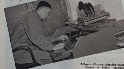
• Dolje: Davanje ploča u emisiju. Uredjaj ima dva konjara, te na vrijeme re-produkcije na jednoj strani tehničar pripravlja drugu stranu za emisiju. Time je omogućeno davanje bez prekida
